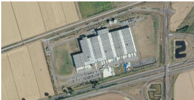
Illustration 3 : Photo aérienne des emprises réalisées – secteur Ouest
